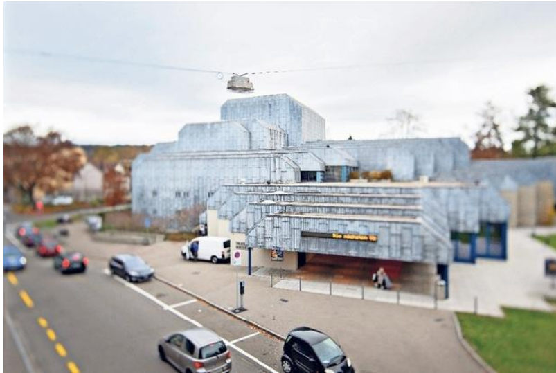
Wird nicht abgerissen: Das Theatergebäude beim Stadtpark steht im kantonalen Schutzinventar. Bild: Michele Limina
