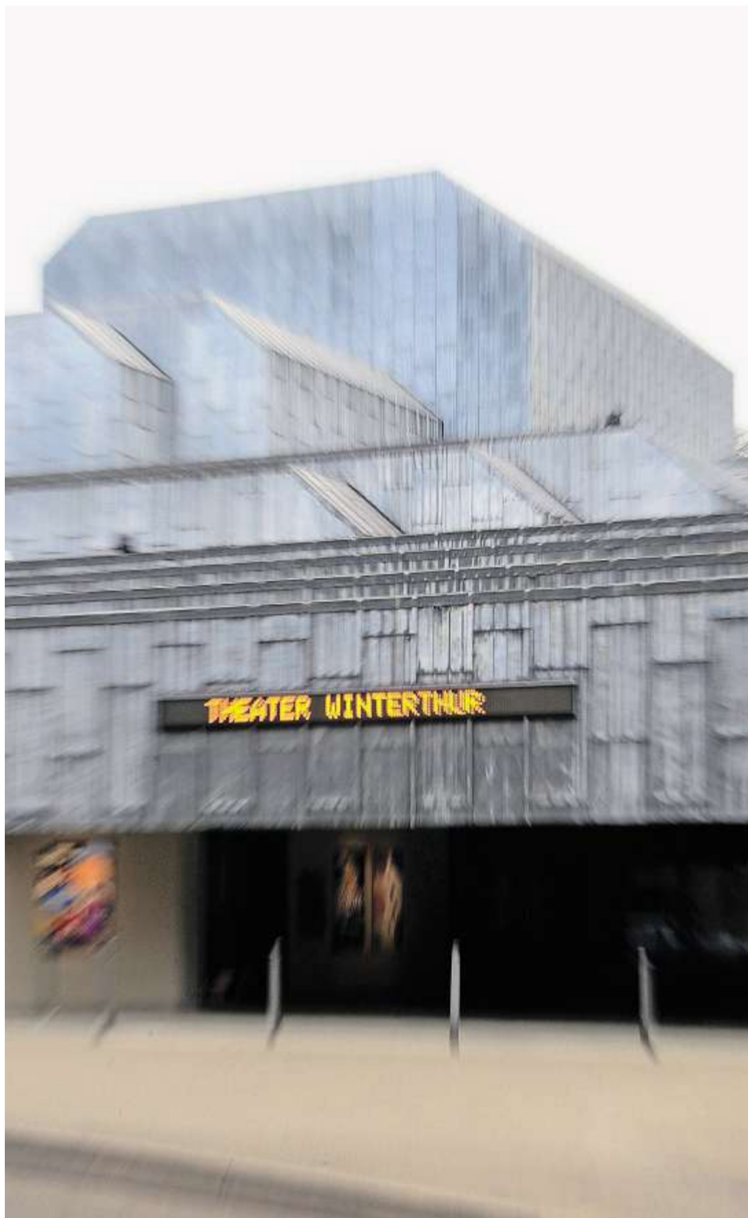
Das Bleidach hält, doch bei der Haustechnik müsste investiert werden: Theater Winterthur.
